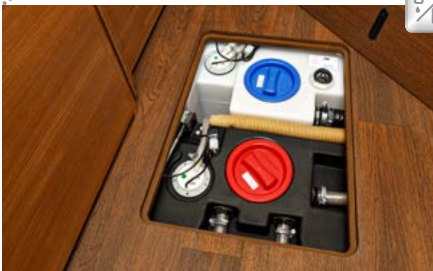
Wassertanks frostsicher im beheizten Doppelboden
